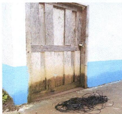
Foto 2: PUERTA DE METAL
