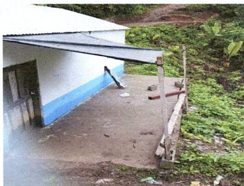
Foto 1: ESTRUCTURA DE TECHO CUBIERTA DE LAMINA, MURO PERIMETRAL
